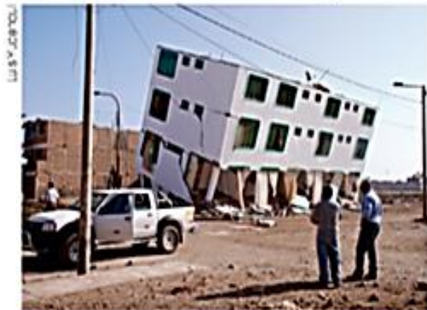
Edificación a punto de desplomarse luego del terremoto de Pisco (2007).
